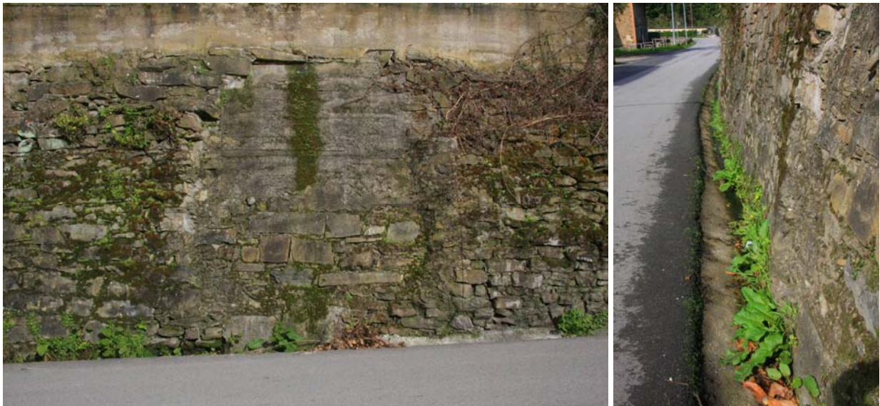
Foto 1. Muro de la carretera a Vegadotos en el que se sitúa la antigua bocamina.
